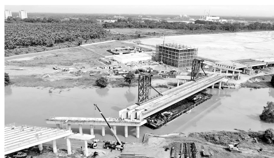
Hình 2. Cầu Sungai Langat – Malaysia sử dụng UHPC – nhịp 105m [11]
