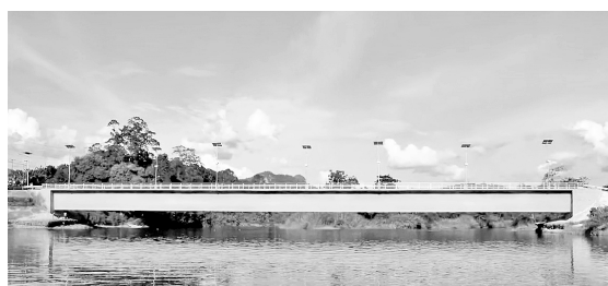
Hình 1. Cầu Batu 6- Malaysia sử dụng UHPC [11]
